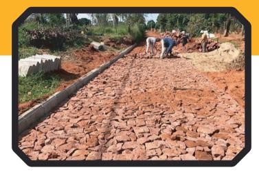
Contamos con personal capacitado para la provisión y colocación de empedrados y adoquines, con cordones.
